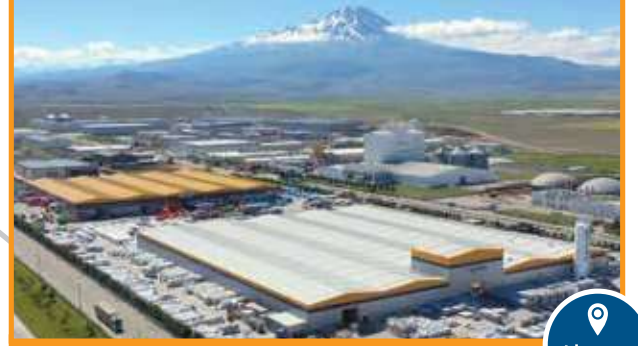
PVC-U ve PP-R Sistem Üretim Tesisi
