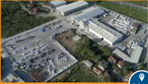
PVC-U Sistem Üretim Tesisi
